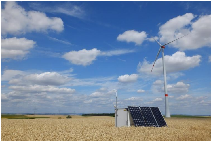
Fig. 3: Medição por LiDAR para teste de performance de turbina
